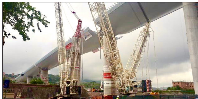
18. ábra: Az utolsó hídelem beemelése
