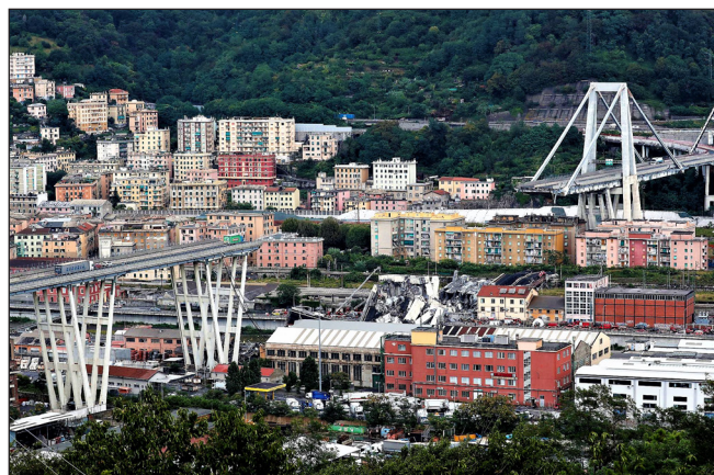
2. ábra: A Morandi-híd az összeomlás után, Genova
